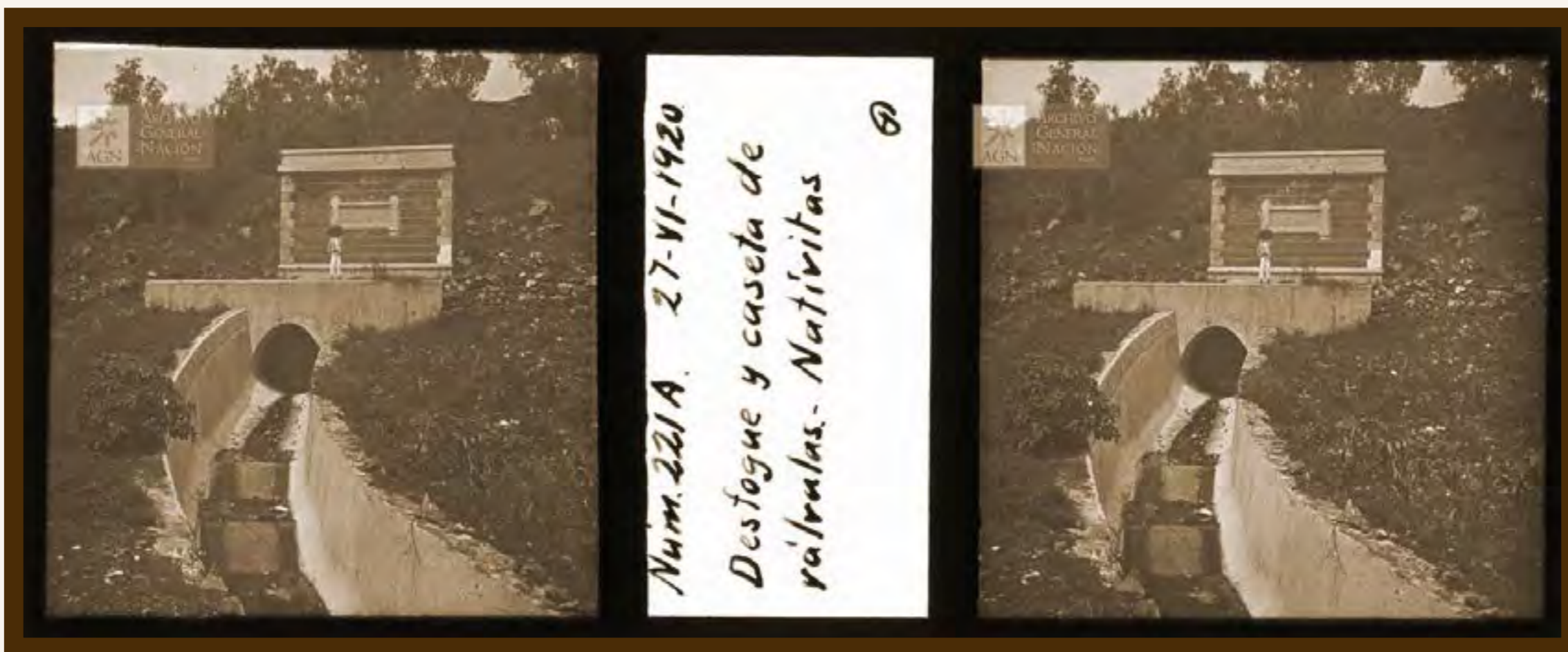
Núm. 221-A 27-VI-20 Desfogue y caseta de válvulas. Nativitas
