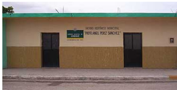
Fachada del Archivo Municipal de González, Tamaulipas
